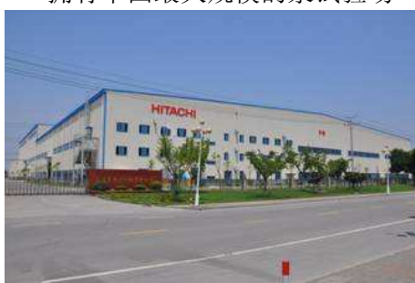
竣工的新工厂外观
