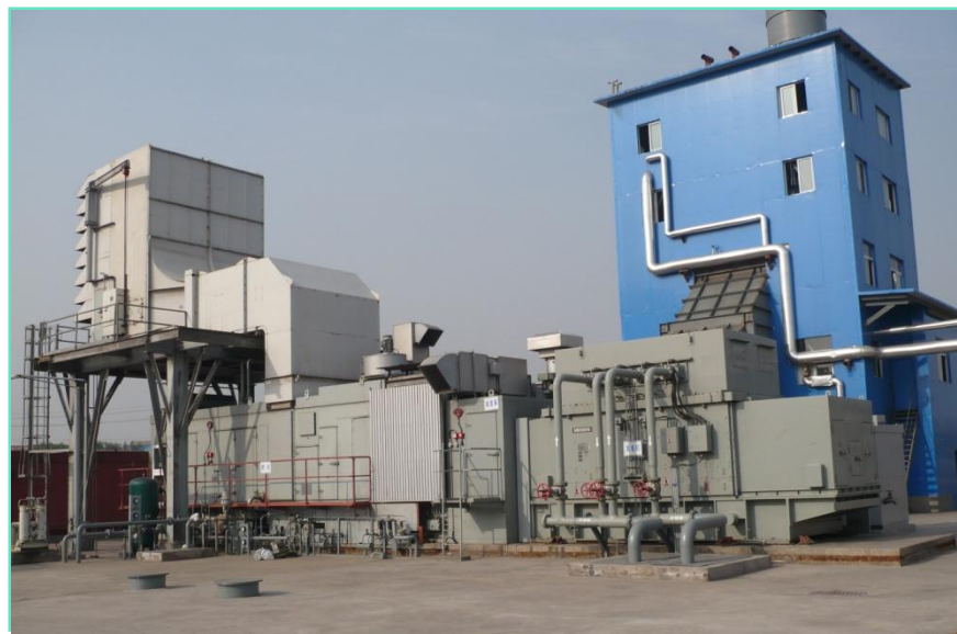
景源热电厂现场
