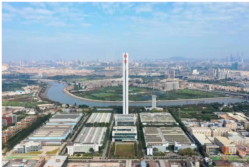
“H1 TOWER”电梯试验塔
