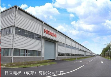
日立电梯（成都）有限公司厂房
