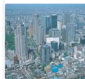
新宿新城中心地带 世界容量最大的 59000RT冷水供给中心
